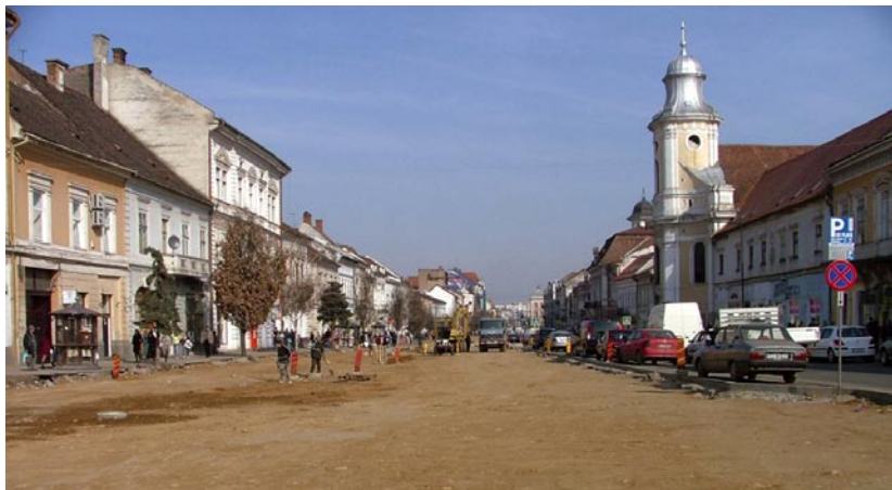
Bulevardul Eroilor în șantier, Cluj
