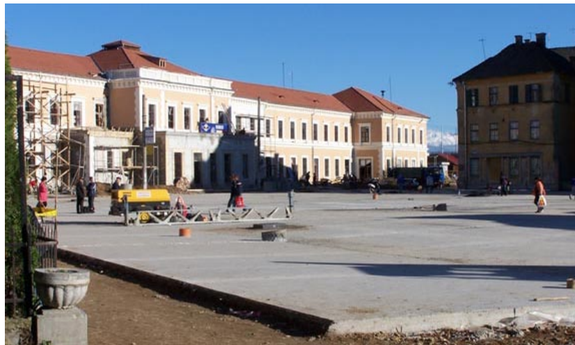
Piața Gării din Sibiu, suprafața pietonală pregătită pentru lucrările de pavare
